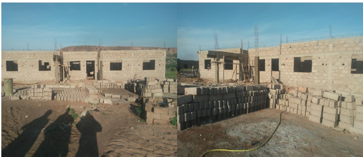
Travaux de construction de la nouvelle brigade de Diamou
