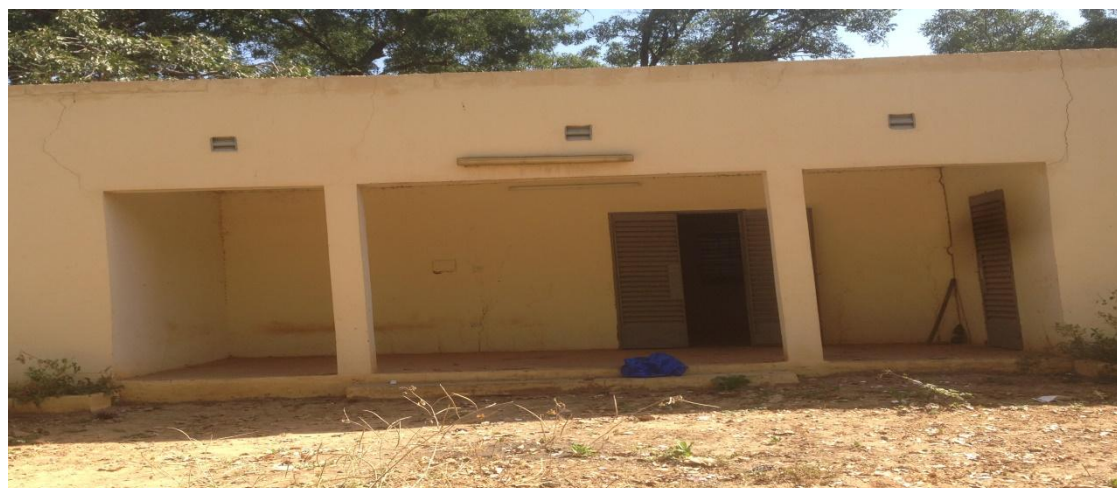
Annexe au logement du préfet de Kolokani
