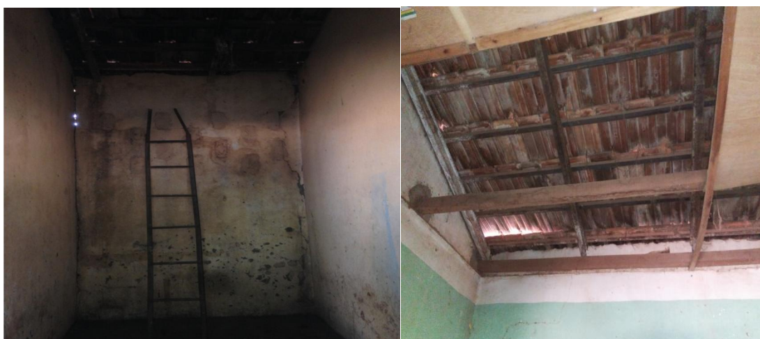
Vue d'intérieur d'une chambre d'annexe et de la toiture
