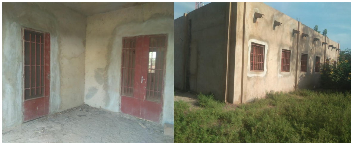
Bureaux de la Compagnie de Gendarmerie de Kita arrêtés aux travaux de finition
